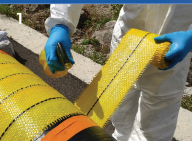
Enveloppement R1D (pulvériser de l'eau en continu)
