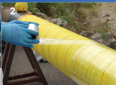
Installation du film de compression
